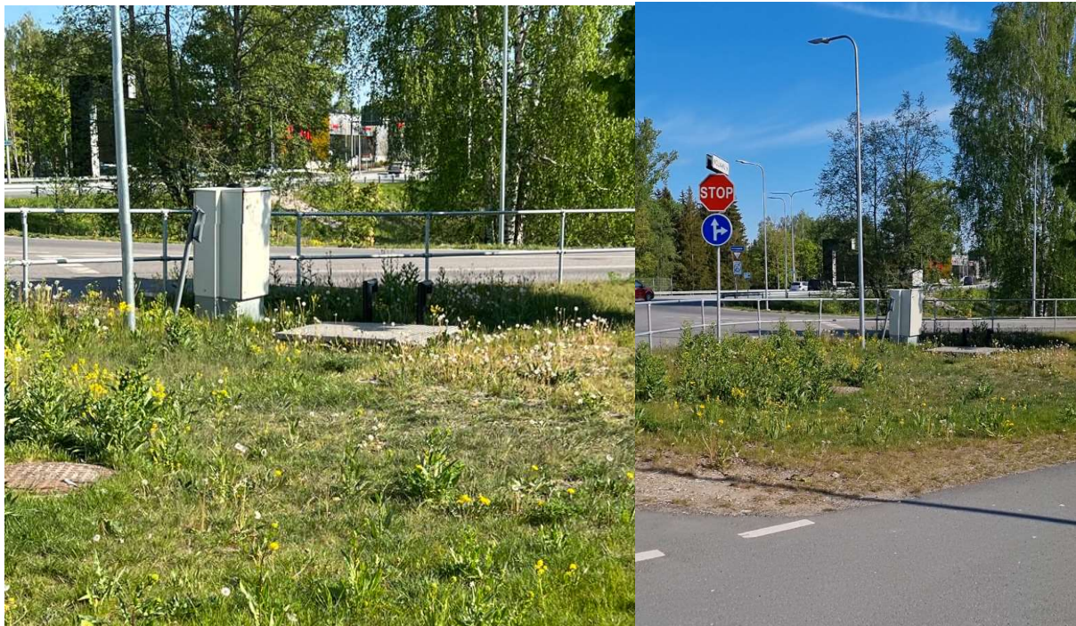
Pilt 3.4 Vanasilla tn olemasolev reoveepumpla (survetoru De160mm)
